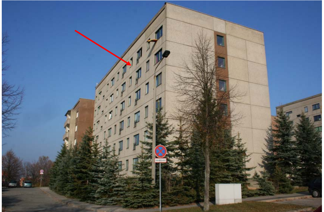
Foto 7: Blick auf das Wohngebäude IO 7 „Makarenkostraße 6“ . Die Giebelseite zeigt in Richtung des geplanten Stadions, die Westfassade (Pfeil) zur Zufahrtsstraße.
