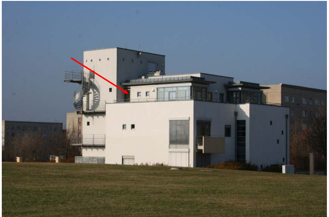
Foto 5: Blick auf die dem geplanten Stadion im Plangebiet zugewandte Südfassade (Pfeil) der Arztpraxis IO 5 „Max-Planck-Straße 12“ .
