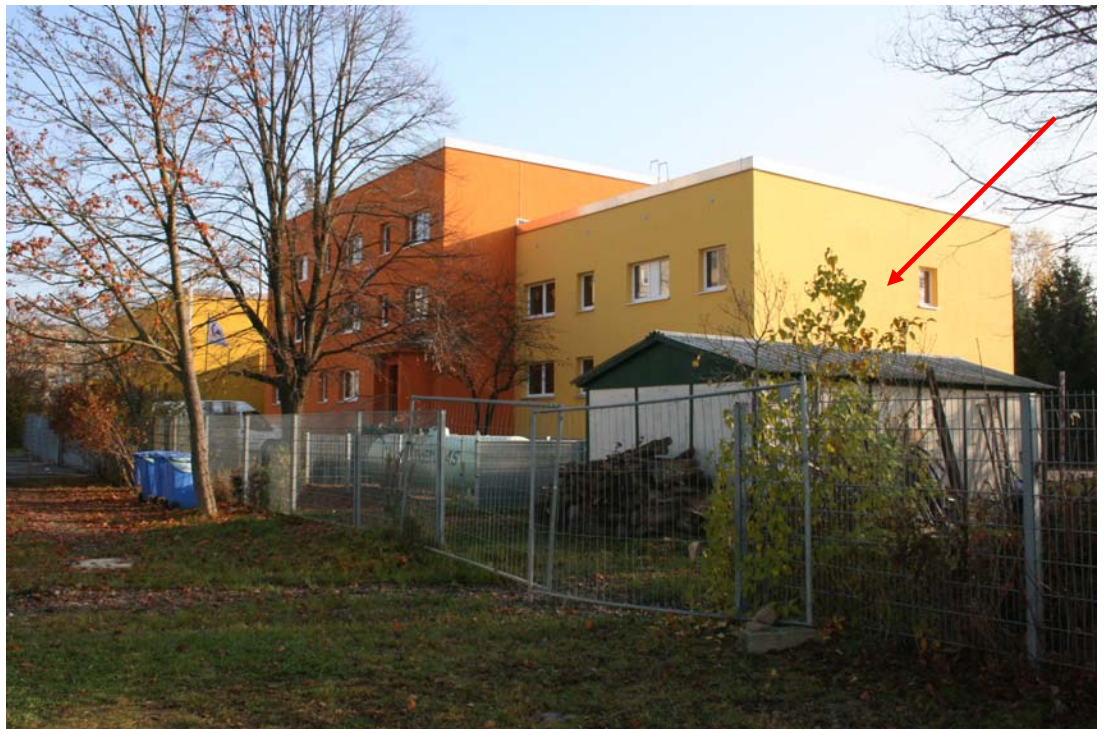
Foto 4: Blick auf die Südfassade des Kindergartens IO 4 „Heisenbergstraße 49“ (rechter Gebäudeteil). Die Westfassade (Pfeil) zeigt in Richtung des geplanten Stadions.
