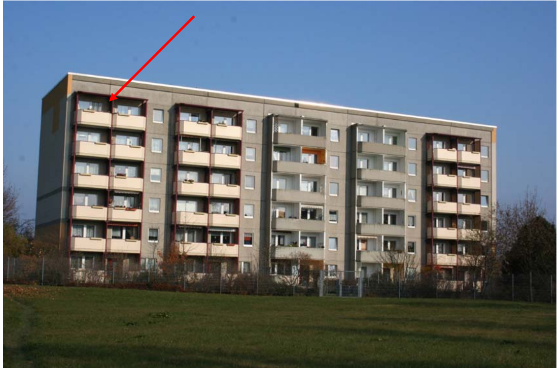
Foto 3: Blick auf die Nordfassade (Pfeil) des Wohngebäudes IO 3 „Albert-Funk-Straße 11“, die in Richtung des geplanten Stadions im Plangebiet zeigt.
