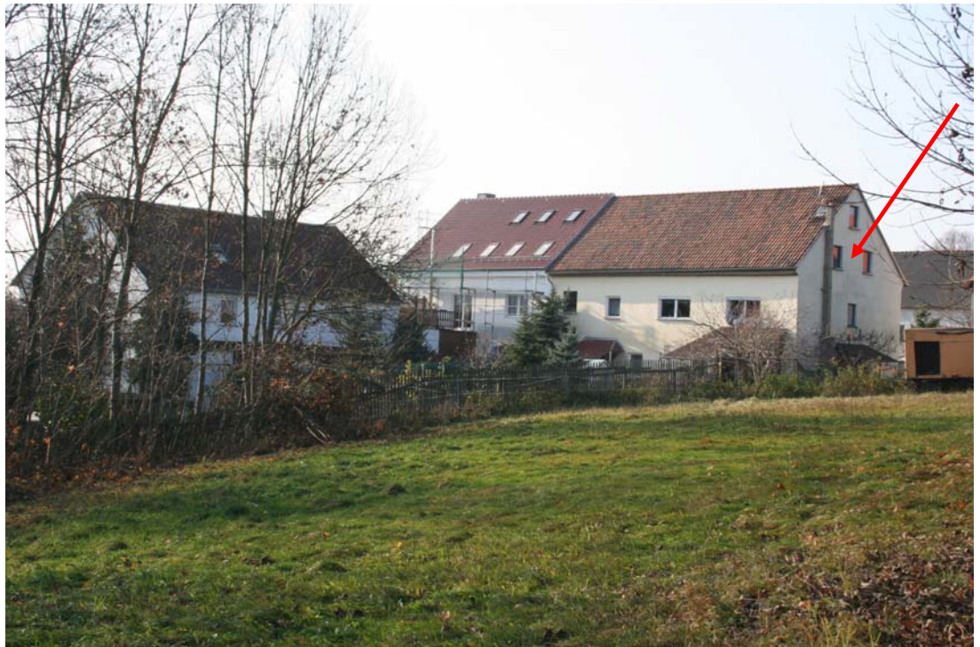
Foto 10: Blick auf die NO-Fassade (Pfeil) des Wohngebäudes IO 10 „Trillerplatz 4“, die in Richtung des geplanten Stadions im Plangebiet zeigt.
