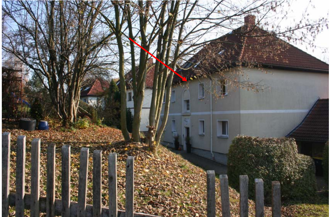
Foto 1: Blick auf die NO-Fassade (Pfeil) des Wohnhauses IO 1 „Mülsener Straße 13“ , die in Richtung des geplanten Stadions im Plangebiet zeigt.
