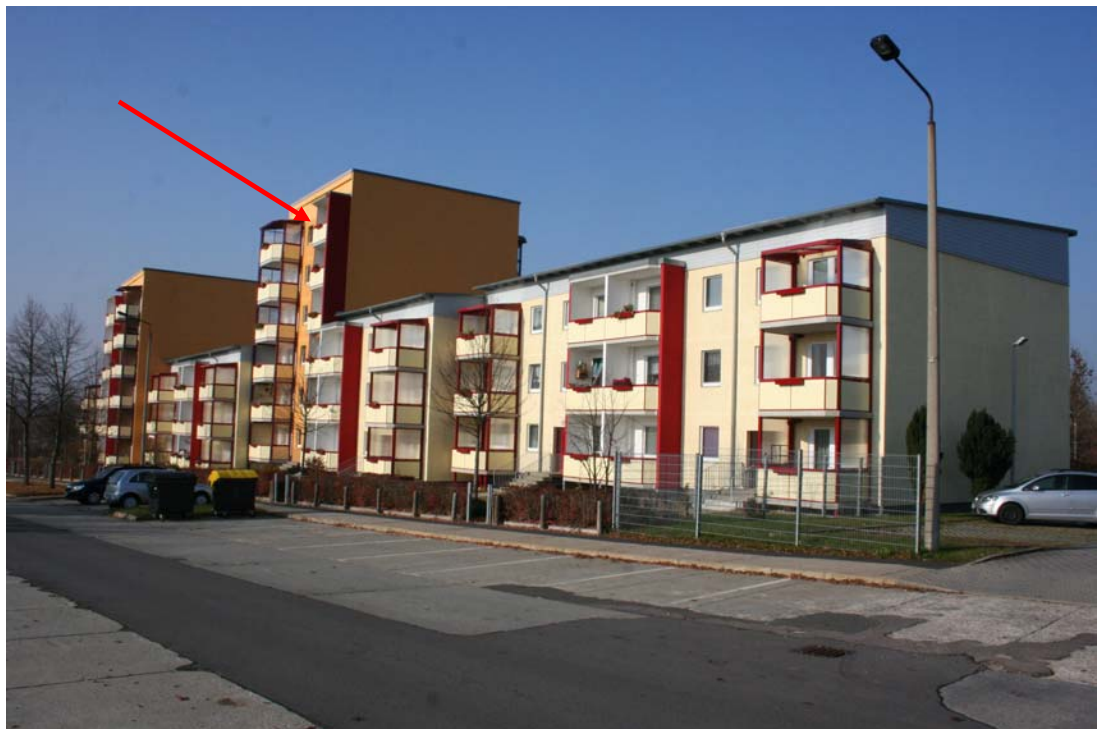
Foto 8: Blick auf die Südfassade (Pfeil) des Wohngebäudes IO 8 „Makarenkostraße 30“ .
