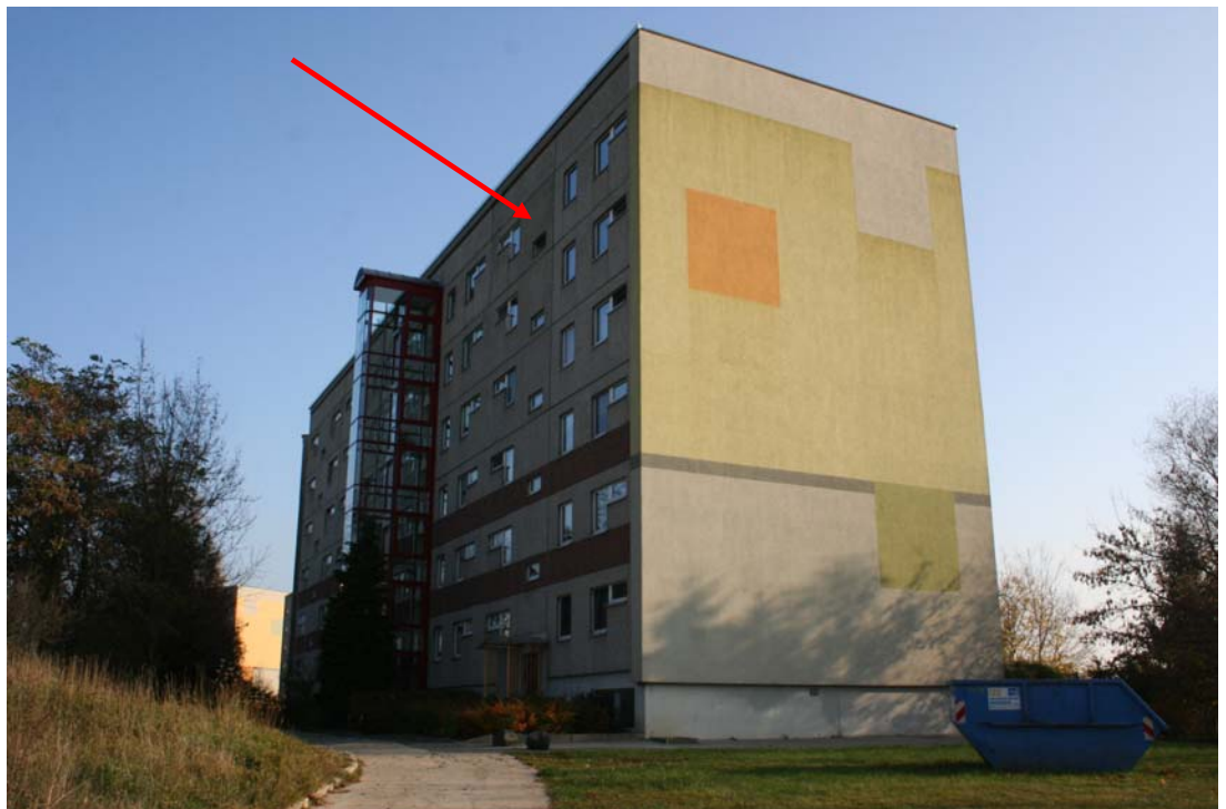
Foto 2: Blick auf die Südwestfassade des Wohngebäudes IO 2 „Albert-Funk-Straße 88“ .
