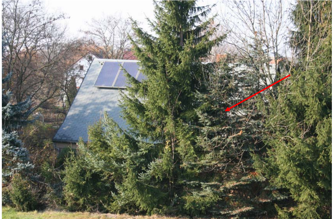
Foto 11: Blick auf das Wohngebäude IO 11 „Trillerplatz 8“ . Der verdeckte Giebel (Pfeil) zeigt in Richtung des geplanten Stadions im Plangebiet.
