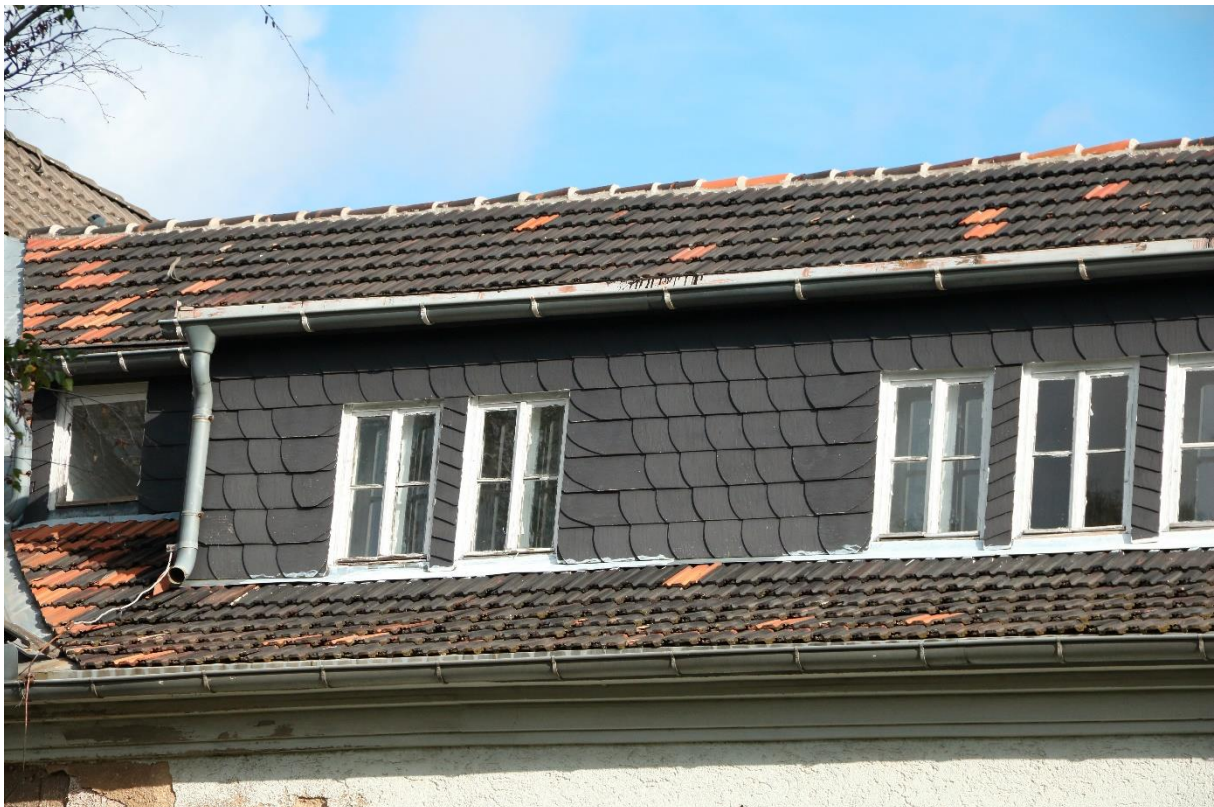
Abbildung 12: Fassadenverkleidung an Haus 1
