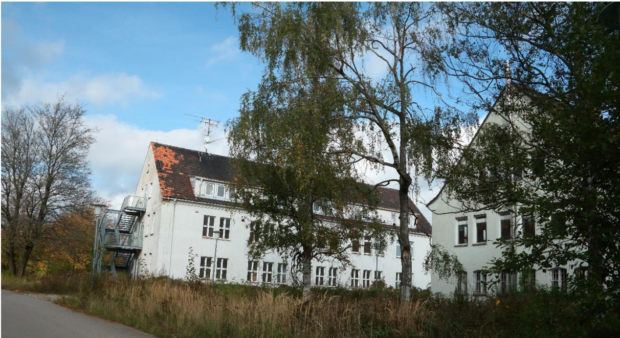
Abbildung 10: Blick auf Haus 2 sowie Teile von Haus 1
