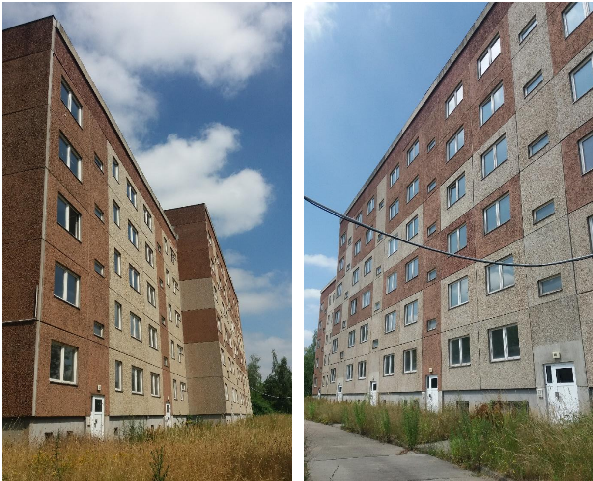
Abbildung 5: Hofansicht (Eingangsseite) des Plattenbaugeschäftes
