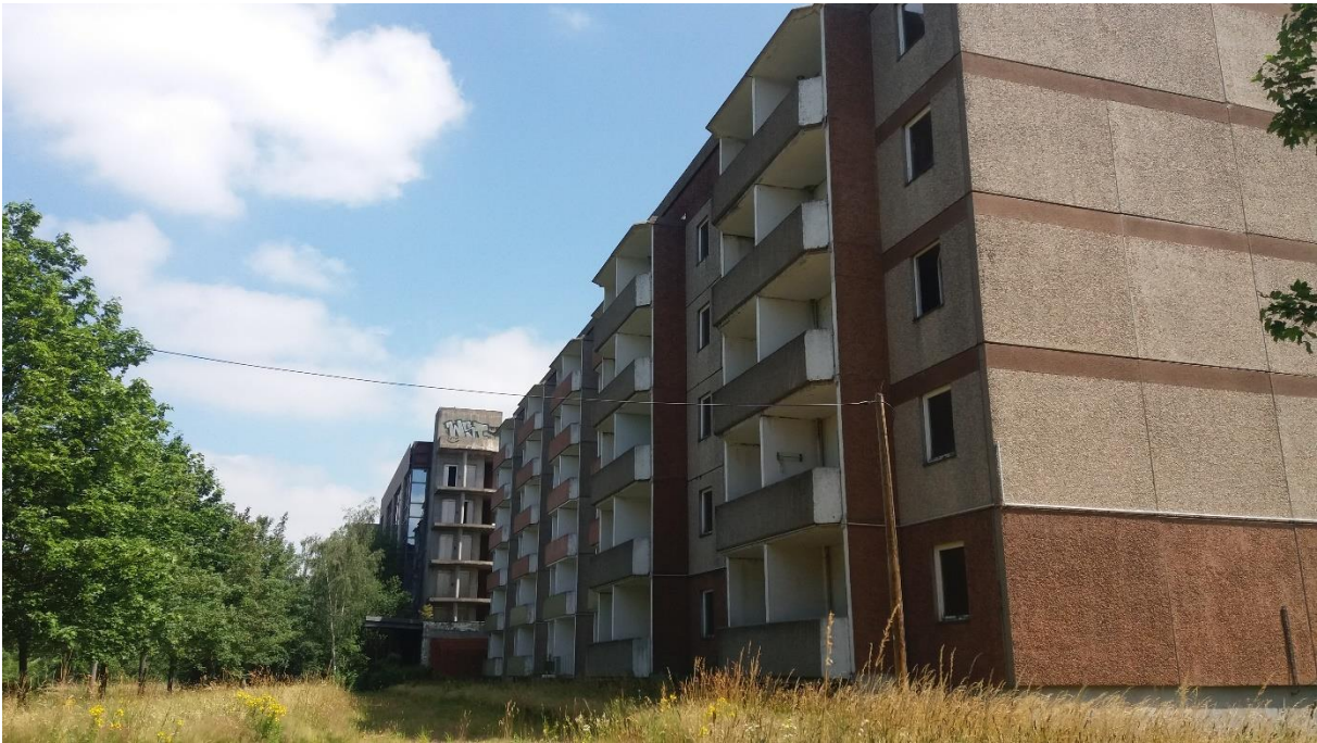
Abbildung 3: Ansicht Straßenseite des Plattenbaus
