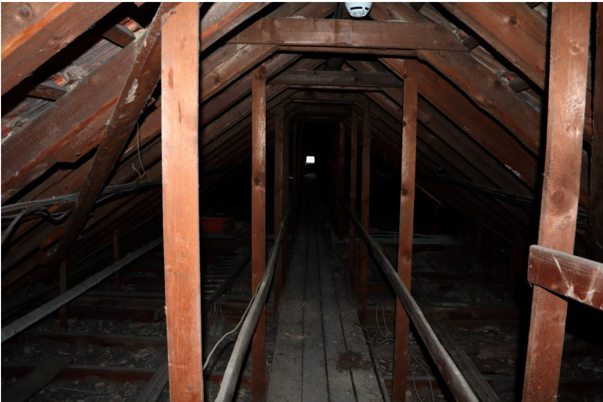
Abbildung 18: Dachraum von Haus 2
