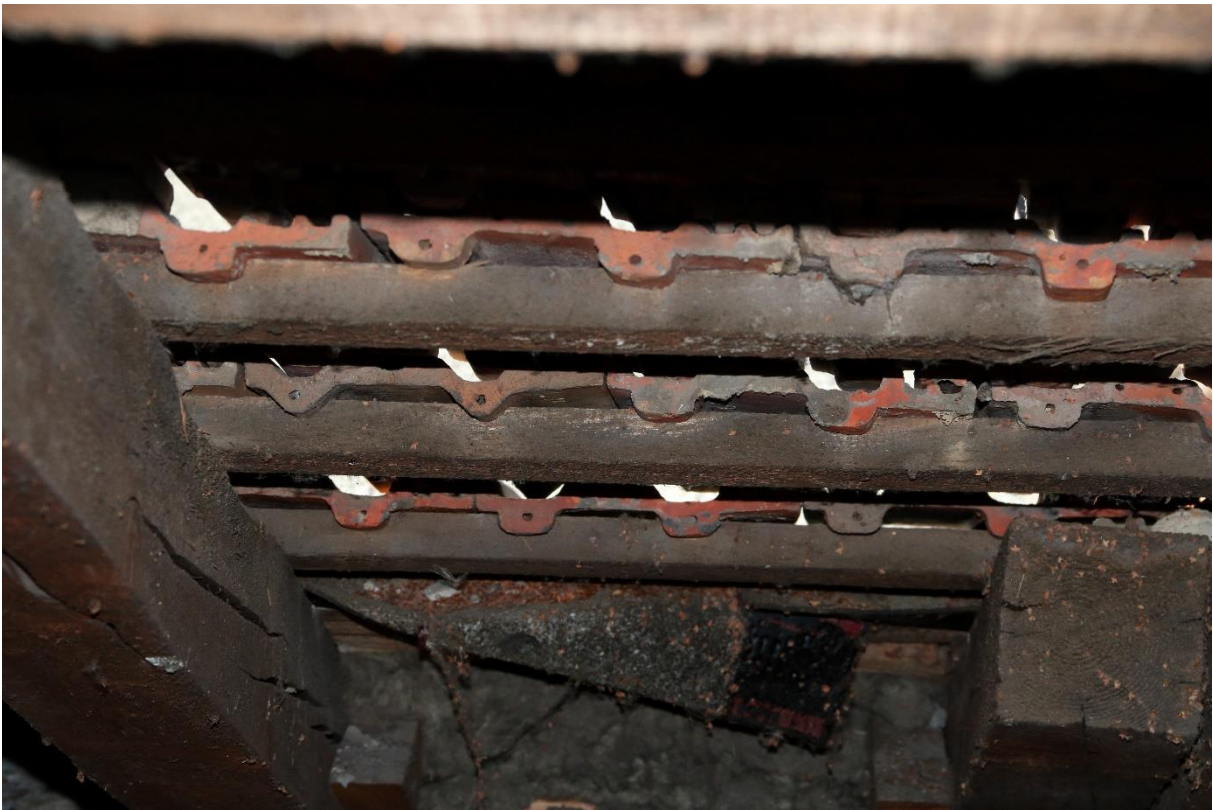
Abbildung 19: Zugangsmöglichkeit für Fledermäuse zum Dachraum
