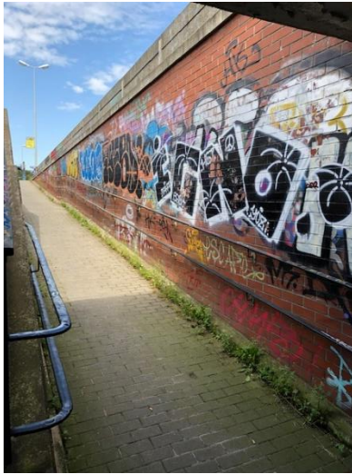
Unterführung Brücke B 93
