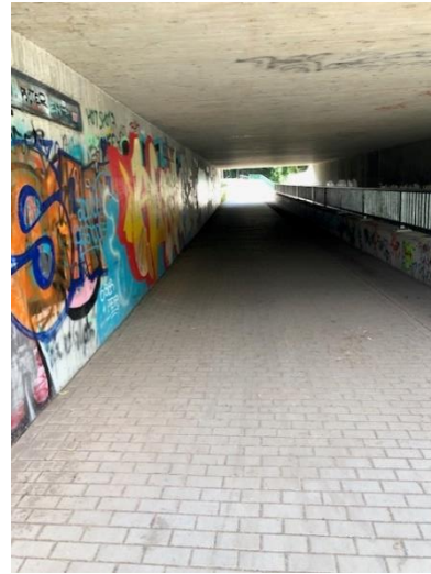
Tunnel am Bachweg
