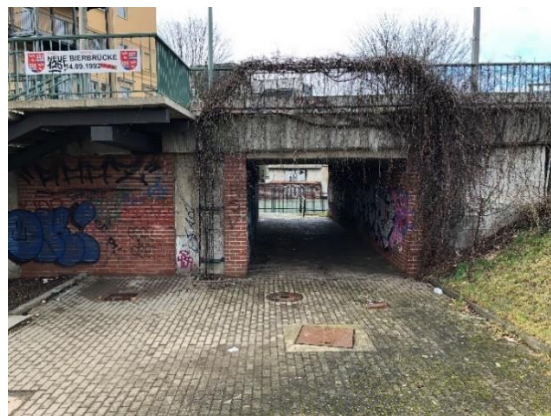
Unterführung Neue Bierbrücke
