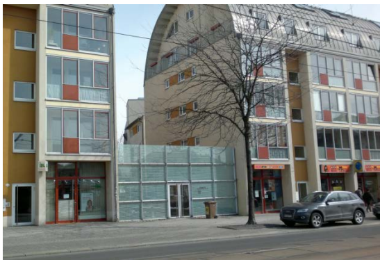
Foto: Lärmschutzwand zur Abschirmung rückwärtiger Bereiche in Dresden
