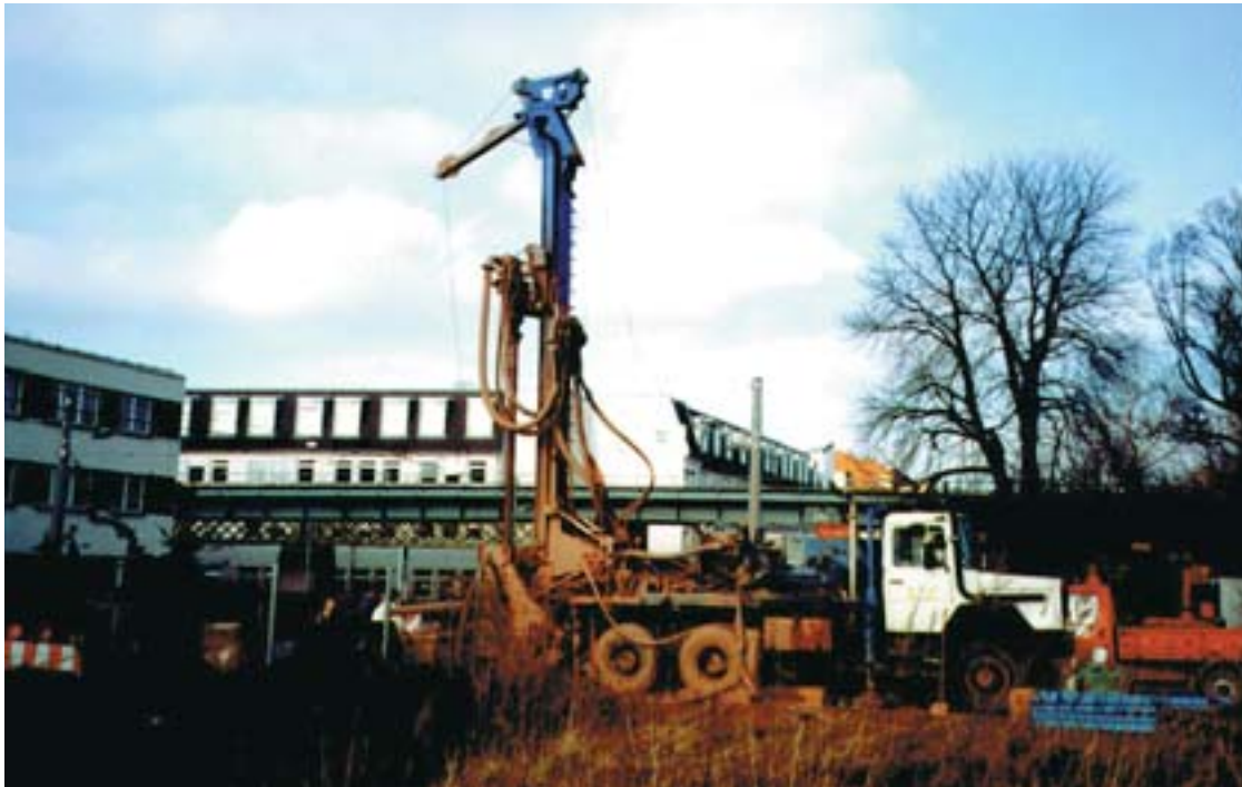
Abb. 11: 180 m - Bohrung auf der Äußeren Schneeberger Straße
