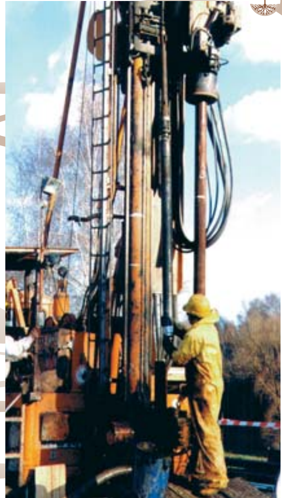
Abb. 10: Bohrarbeiten auf dem Muldendamm
