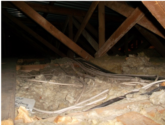
Provisorisch ausgelegte Mineralwolle im Kriechboden
