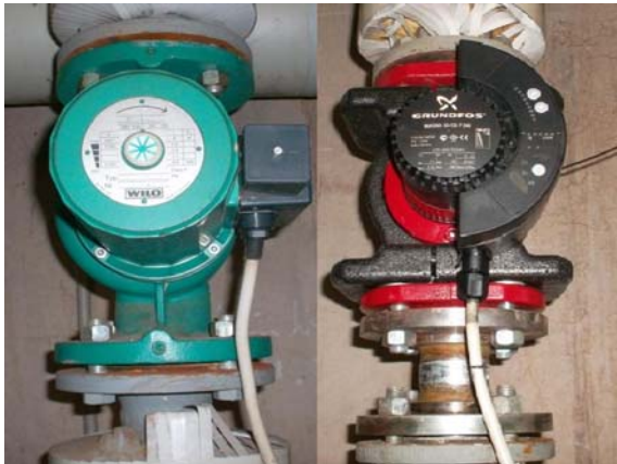
Links: konservative Umwälzpumpe, vierstufig (6 Stück) Rechts: Hochenergieeffizienz-Umwälzpumpe (1 Stück)
