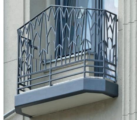
Die kleinen Balkone auf der Straßenseite wurden saniert und die historischen Geländer wieder instandgesetzt. Auf der Rückseite des Gebäudes wurden die bestehenden Balkone vergrößert und am Anbau neue Balkone mit einer Stahlkonstruktion montiert. Auf der Dachfläche des Anbaus ist eine Dachterrasse entstanden, die einer der Wohnungen zugeordnet ist.
