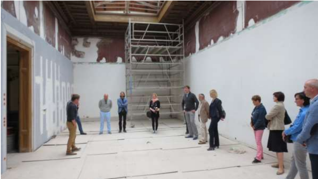
Baustellenbesichtigung Galerie am Domhof
