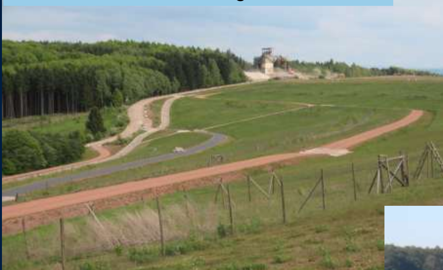
IAA Helmsdorf Sanierung Westdamm
