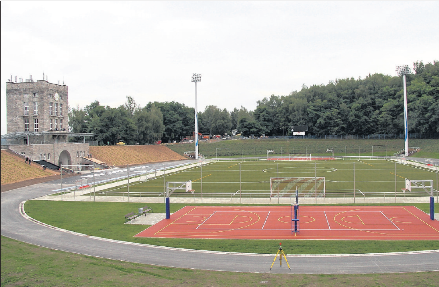
NUR NOCH WENIGE RESTARBEITEN SIND IN DER MULTIFUNKTIONALEN SPORTSTÄTTE WESTSACHSENSTADION ZU ERLEDIGEN, BEVOR DIESE AM FREITAG DER KOMMENDEN WOCH E OFFIZIELL AN DIE BREITEN- UND VEREINSSPORTLER ÜBERGEBEN WIRD. FOTO: STADT ZWICKAU
