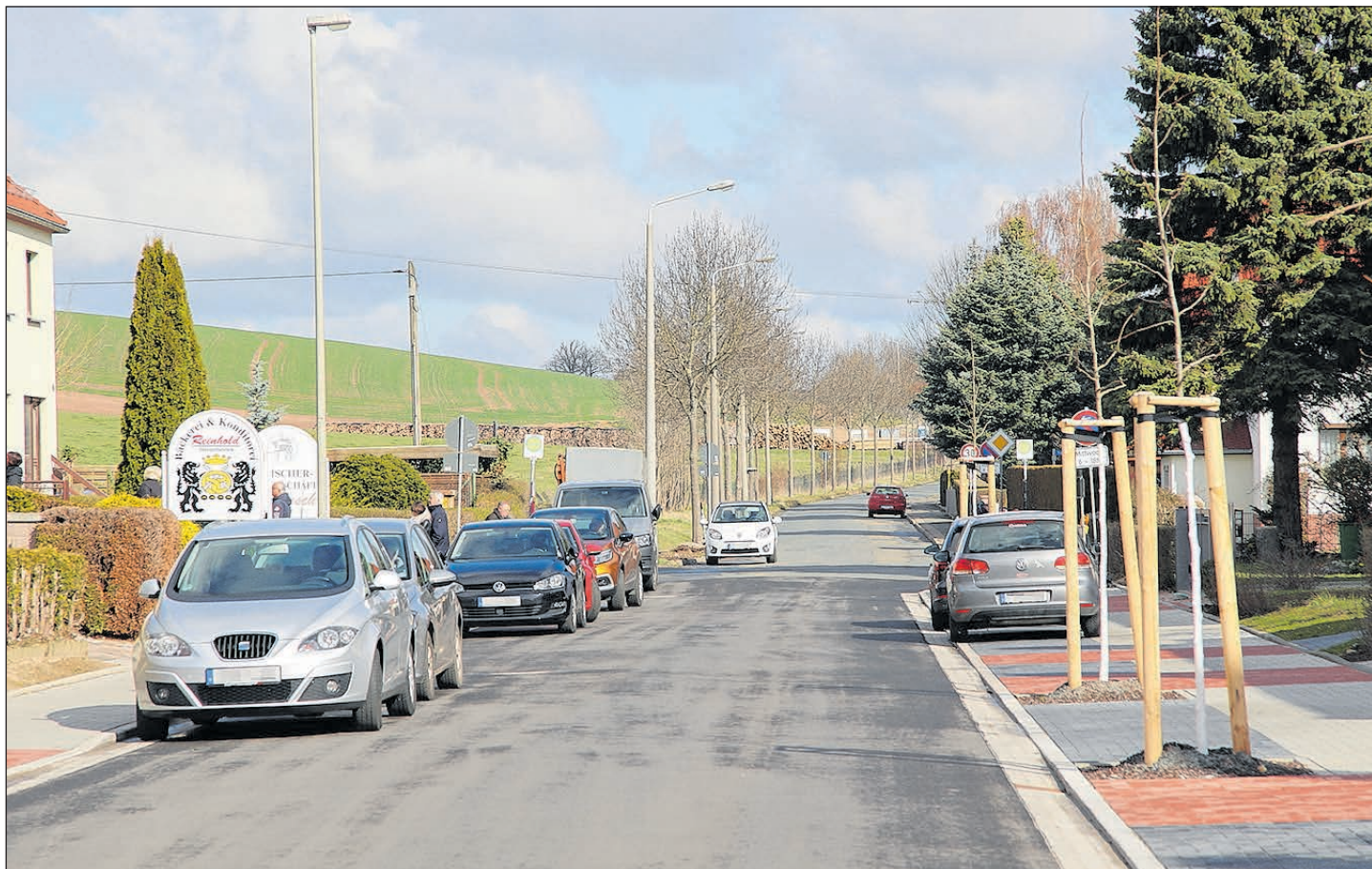
IN WEISSENBORN WIRD AKTUELL DER AUSBAU DER FRÜHLINGSSTRASSE FORTGESETZT. IN DEN BEIDEN VERGANGENEN JAHREN WURDE BEREITS DER ABSCHNITT ZWISCHEN KUHBERGWEG UND FRÜHLINGSSTRASSE 43 UMFASSEND ERNEUERT. FOTO: STADT ZWICKAU
