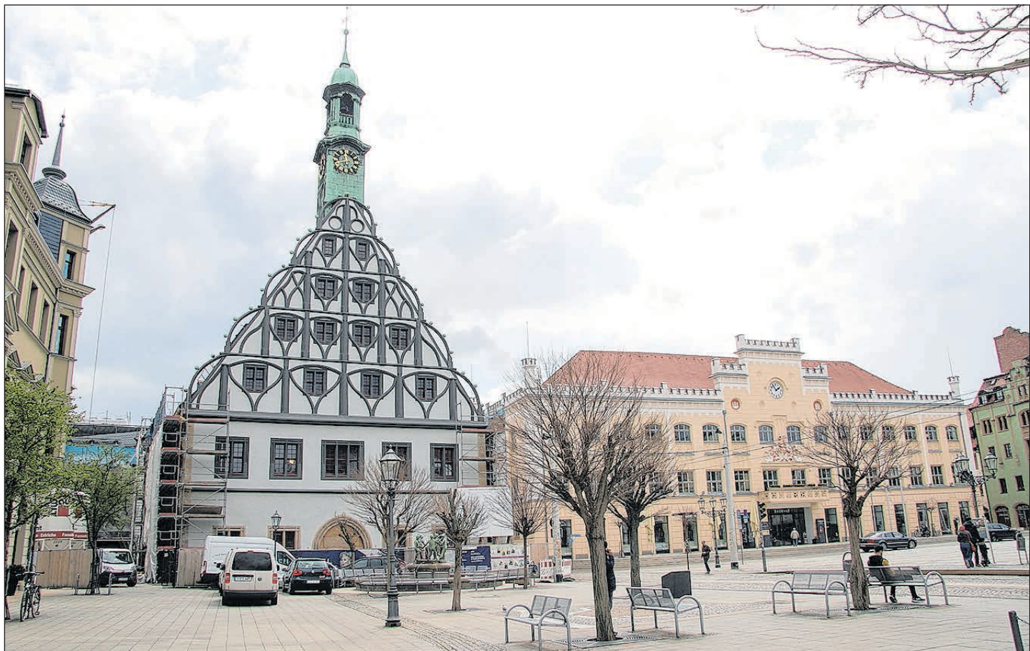
AM MONTAG DER VERGANGENEN WOCHE WURDE DAS GERÜST AN DER NORDSEITE DES GEWANDHAUSES ZURÜCKGEBAUT. NUNMEHR SICHTBAR IST DER AUFWÄNDIG SANIERTE RENAISSANCEGIEBEL MIT GRAU-WEISSER FASSUNG NACH HISTORISCHEM VORBILD. FOTO: STADT ZWICKAU
