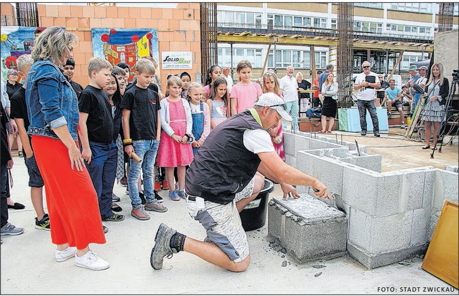
DIE SCHÜLER DER ADAM-RIES-SCHULE WAREN DABEI, ALS AM 29. JUNI DER GRUNDSTEIN FÜR DAS MEHRZWECKGEBÄUDE AUF DEM GELÄNDE DES NEUPLANITZER SCHULSTANDORTES GEGLEGT WURDE. ZUM JAHRESENDE SOLL DER BAU FERTIG SEIN.
