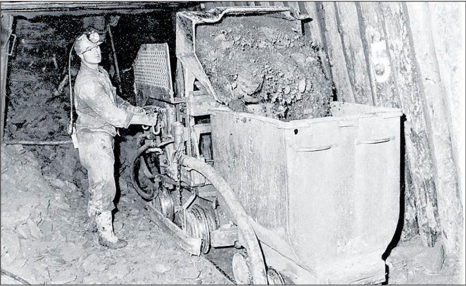
STRECKENVORTRIEB – BELADEN VON FÖRDERWAGEN MIT BAGGER. FOTO: WISMUT GMBH
