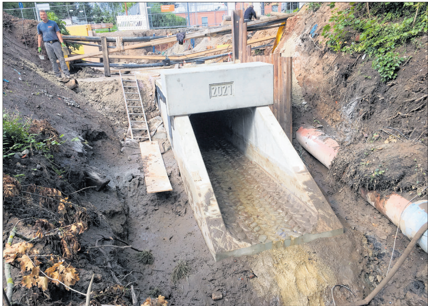
DAS 100 METER LANGE DURCHLASSBAUWERK VERHINDERT ZUKÜNFTIG EIN UNTERSPIÜLEN DER VERKEHRSFLÄCHE. FOTO: STADT ZWICKAU
