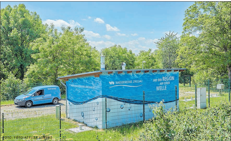
IN REGENÜBERLAUFBECKEN WIE DIESEM AN DER WERDAUER STRASSE IN ZWICKAU KANN MISCHWASSER BEI STARKEN REGENFÄLLEN GESPEICHERT UND GEZIELT INS KANALSYSTEM ABGELEITET WERDEN. SO WIRD VERMIEDEN, DASS KANALISATION UND KLÄRANLAGEN ÜBERLASTET WERDEN.
