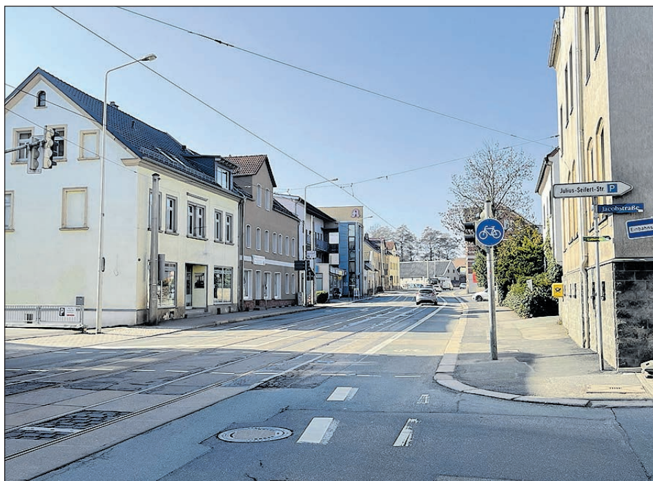
ZWISCHEN EINMÜNDUNG JACOBSTRASSE UND HAUSNUMMER 158 WIRD DIE MARIENTHALER STRASSE NACH OSTERN VOLLGESPERRT. FOTO: STADT ZWICKAU
