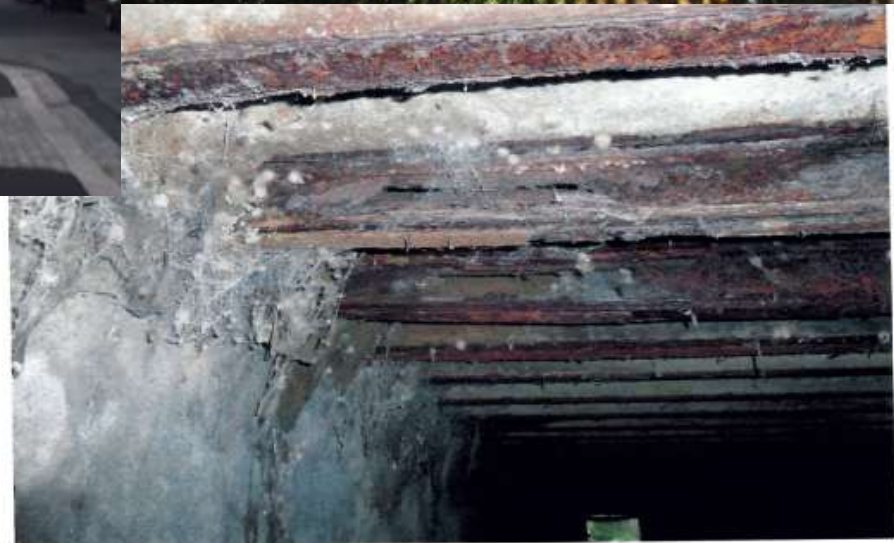
5 Zustand Deckenträger am Auflager, Komplettdurchrostung
