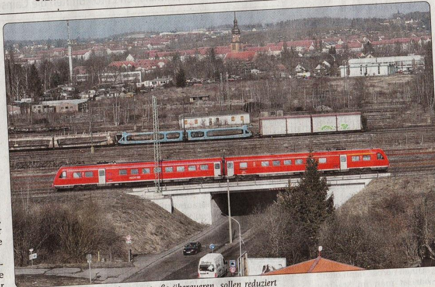
Die Gleisanlagen, die die Olzmannstraße überqueren, sollen reduziert und die Brücke soll 2014 saniert werden. Foto: Bert Harzer
