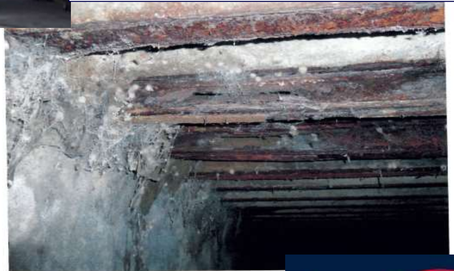
5 Zustand Deckenträger am Auflager, Komplettur
