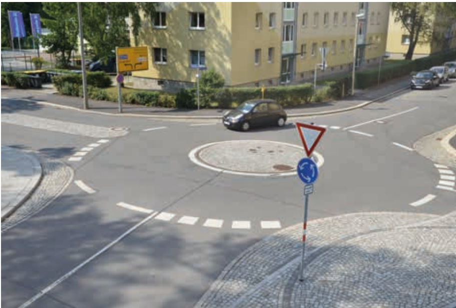
Neuer Mini-Kreisel in Zwickau (Saarstraße / Lothar-Streit-Straße)
