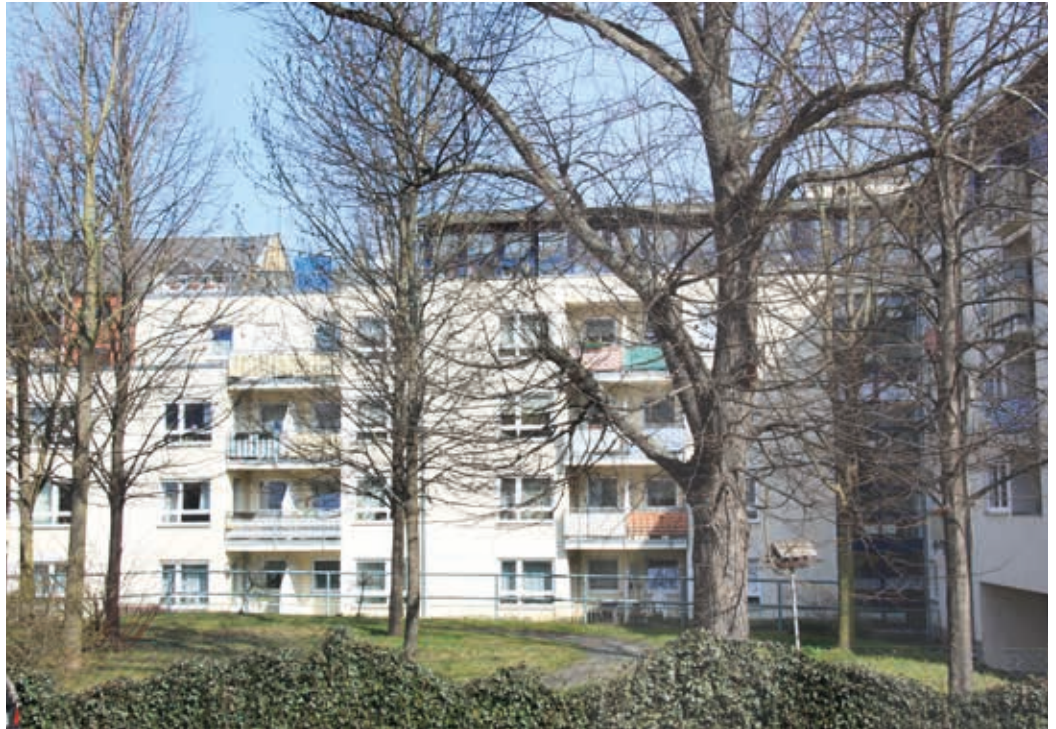
Stadtteil Bahnhofsvorstadt – Wohnanlage Brunnenstraße
