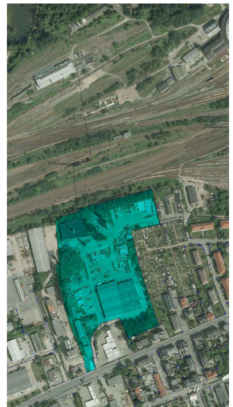
Luftbild ZUG, Betriebsgelände mit Halle
