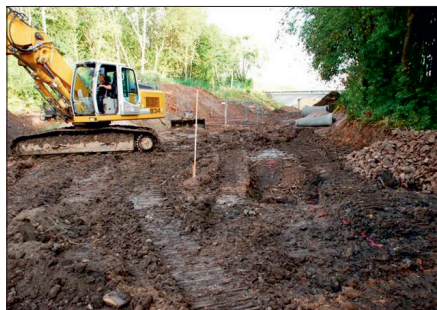
Baustart Deponiesanierung / Bau Regenrückhaltebecken Foto: © WWZ/RZV
