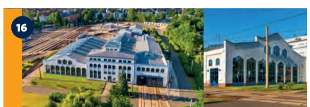
Das 1925 errichtete Gebäude mit seinen beträchtlichen Abmessungen von 25,2 mal 53,5 Metern ist ein sehr früher, stützenfreier Eisenbetonbau, der durch seine Architektur auffällt und noch heute seine Funktion als Straßenbahnbetriebshof erfüllt.
