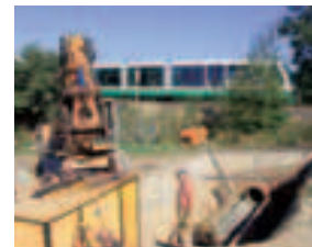
Durchpressung der Bahnlinie für die Entleerungsleitung des Hochbehälters
